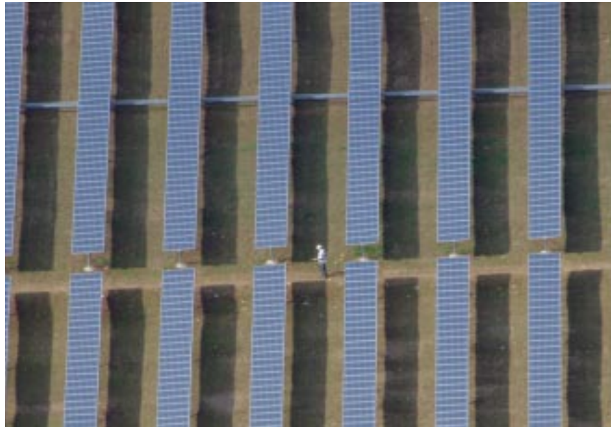
Abb. 1: Über 57 000 Solarmodule wurden für den 10-Megawatt-Solarpark Bavaria auf einachsigen Nachführungssystemen installiert. Der amerikanische Projektierer PowerLight Corp. beauftragte das Fraunhofer ISE mit allen Stufen der Qualitätssicherung – von der Ertragsprognose bis zum Monitoring.
