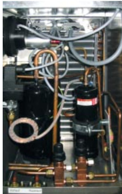
Abb. 1: Abluft-Wärmepumpe in einem geöffneten Lüftungs-Kompaktgerät (Stellfläche 0,5 m 2 ). Sie nutzt die sensible und die latente Wärme der Abluft als Wärmequelle und deckt so den gesamten Bedarf an Heizwärme und an Trinkwasserwärme eines Passivhauses. Die Umstellung auf Kältemittel ohne klimaschädliche FKW ist ein Ziel unserer Entwicklungsarbeiten.
