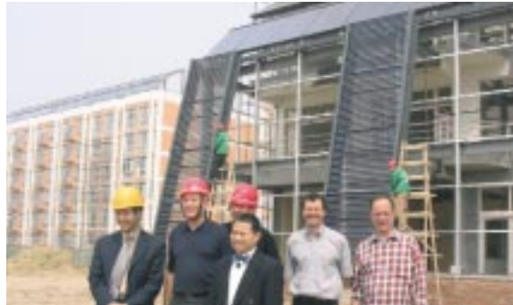
Abb. 1: Niedrigenergiegebäude in Dezhou, China. Das Fraunhofer ISE entwickelt standortgerechte Lösungen für energieoptimierte Gebäude und deren Energieversorgung.
