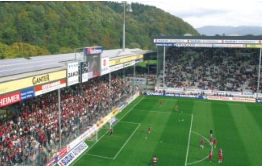
Abb. 2: Das neue Solarkraftwerk mit 90 Kilowatt Leistung auf der Nordtribüne des Freiburger badenova-Stadions ist die erste Anlage des 1-Megawatt-Projekts »Regiosonne«. Auch hier übernahm das Fraunhofer ISE das gesamte Qualitätsmanagement.
