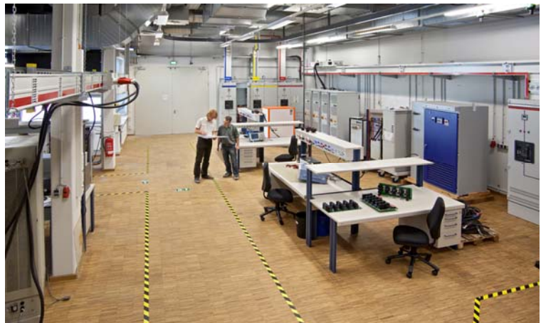
Foto 1: Blick in das neue Megawattlabor am Fraunhofer ISE zum Test von Wechselrichtern bis zu einer Leistung von einem Megawatt. ©Fraunhofer ISE
